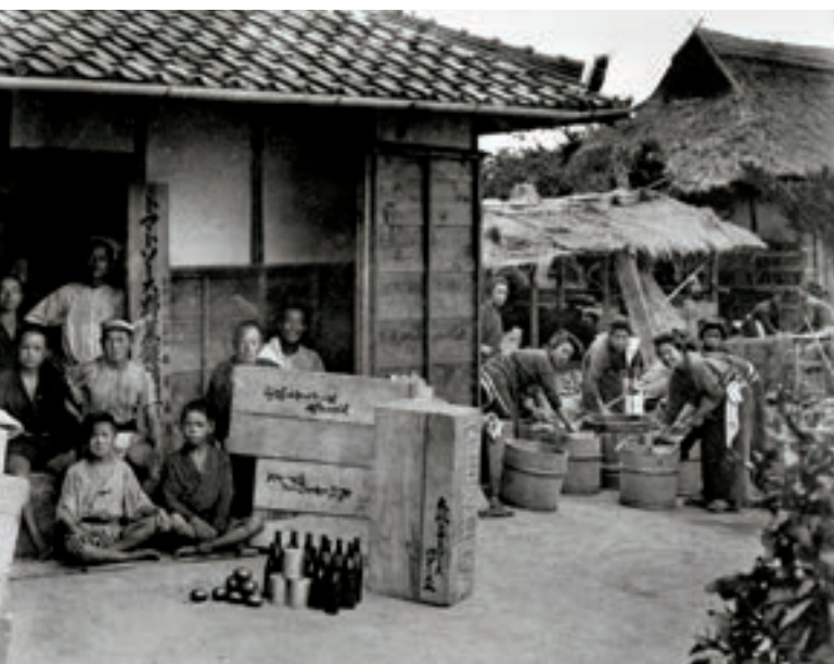
最初の工場とトマトの裏ごし作業 (1910年頃)
