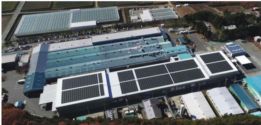
太陽光パネルが設置された富士見工場の様子
