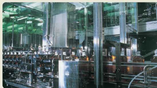
クリーンルーム
