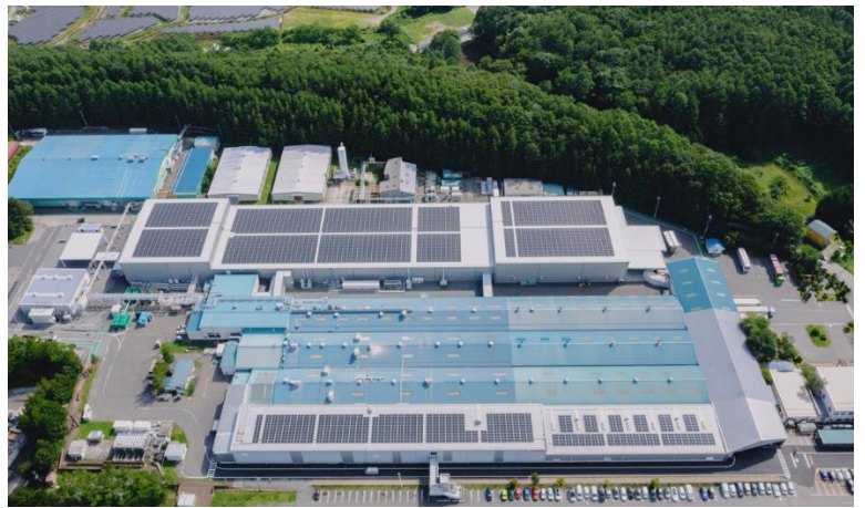
太陽光発電パネルが設置された富士見工場の様子
